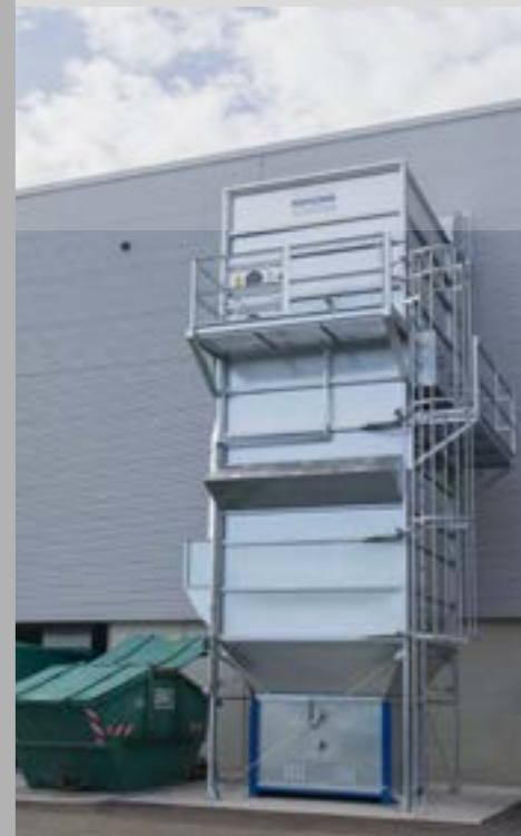
Papierstäube einfach und sicher lagern. Die BrikStar C in einer Druckerei kombiniert mit einem MultiStar Filter.
