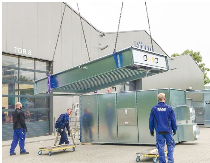
Do montażu hybrydowych filtrów MultiStar konieczne jest użycie dźwigu. Całość prac zajmuje kilka godzin.
