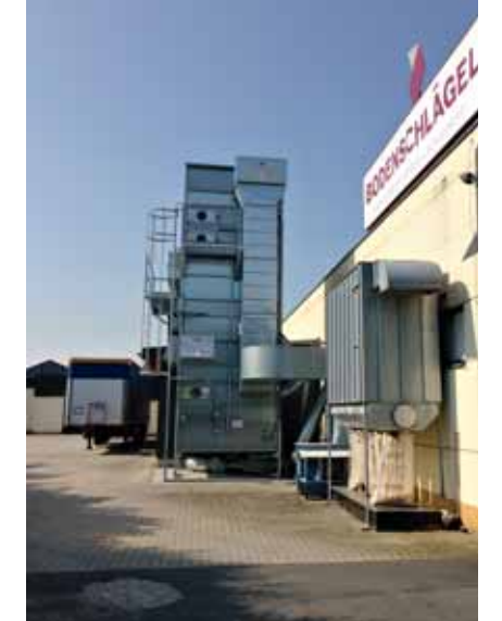
Die gereinigte Luft fließt bei Bodenschlägel zurück in das Gebäude, was die Wärmeverluste minimiert
