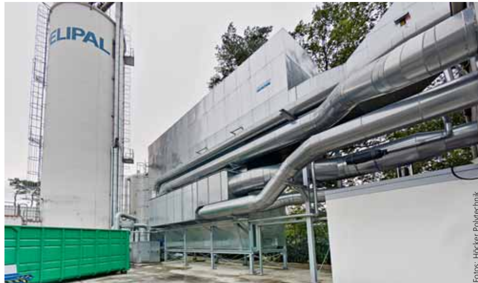
Gut zu sehen, kaum zu hören: Dieser „Multi Star“-Spülluftfilter ist mit 35 dB(A) akustisch kaum wahrnehmbar. Bild unten: Badmöbelfertigung unter modernsten Bedingungen bei Pelipal
