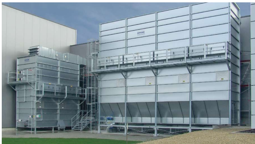
Zwei MultiStar Filteranlagen liefern den Unterdruck für die Entsorgung
