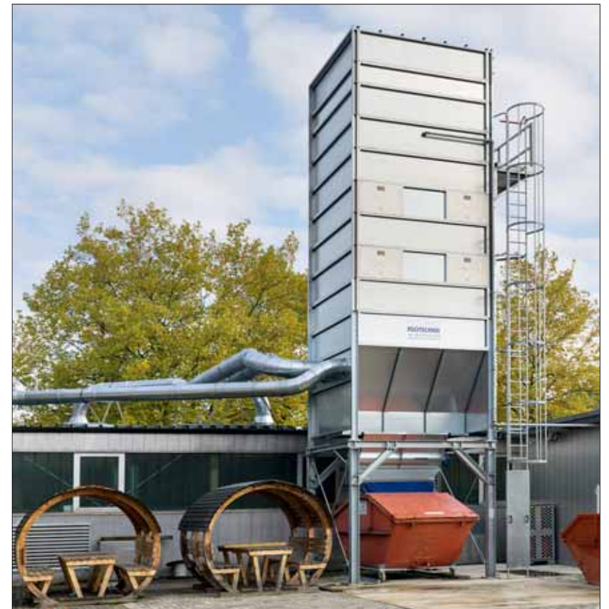
„Multistar VQ-6-6“ auf dem Innenhof der FH Melle: Die Filteranlage steht auf einem erhöhten Untergestell zur Aufnahme mobiler Container.
