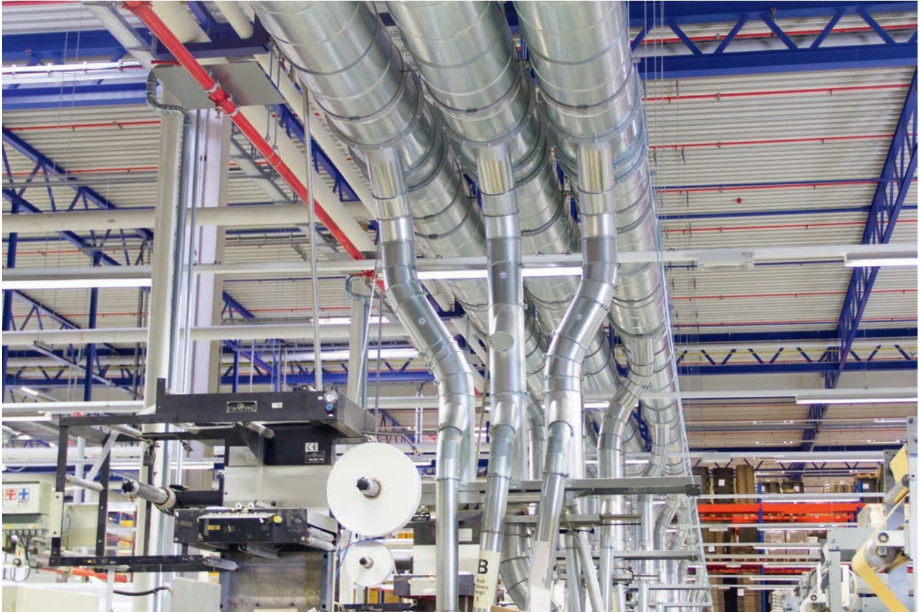
Maschinenhalle bei Bong Solingen: Materialtrennung über jeweils einen Sortenschieber pro Maschine.
