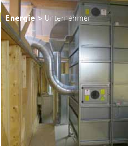
Die MultiStar-Filteranlage mit den Leitungen für Zu- und Abluft
