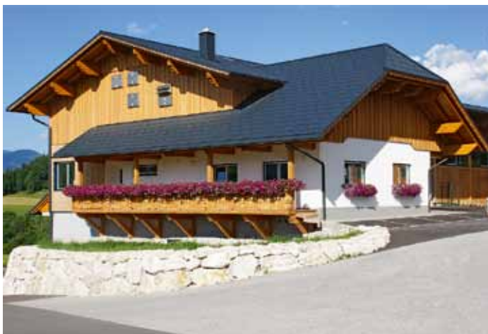
Die Zimmerei in der Außenansicht: Im Giebel deuten nur die Berstscheiben auf den Filter hin
