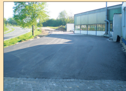
So sah das Gelände vor Beginn der Bauarbeiten aus. Foto: Höcker Polytechnik
