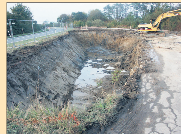
Die Erdarbeiten gingen zügig vonstatten.
