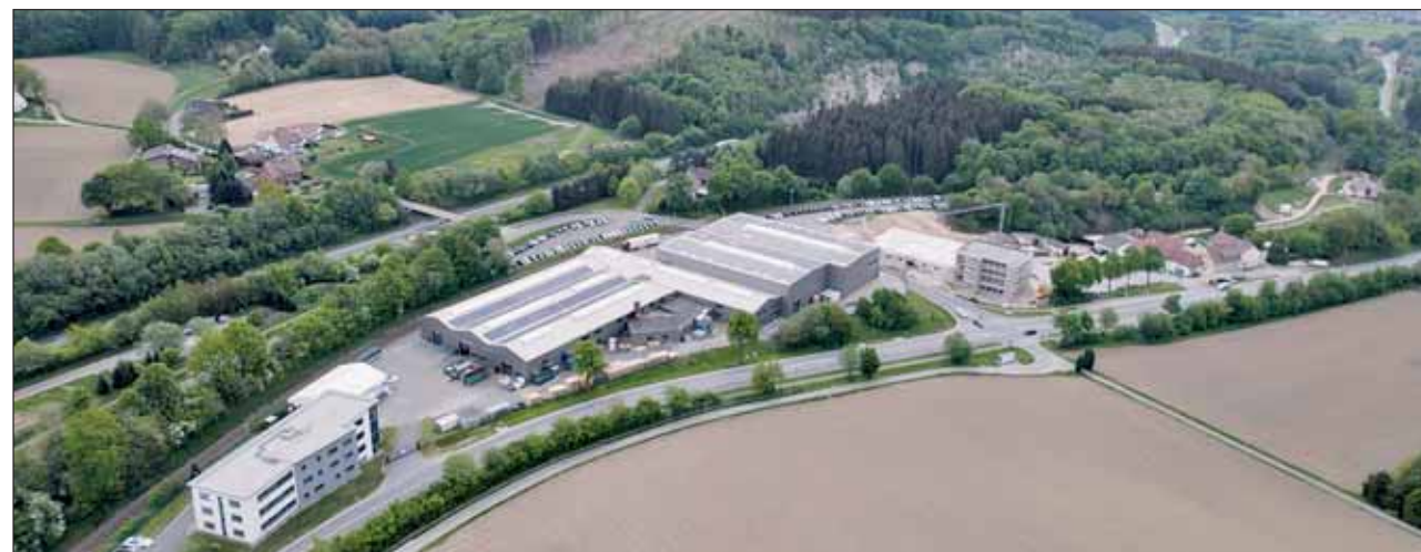
Höcker Polytechnik wächst am Standort Hilter kontinuierlich: Firmengelände im September 2022 – Büro-, Produktions- und Logistikhalle mit Neubau an der Borgloher Straße Fotos: Höcker Polytechnik
