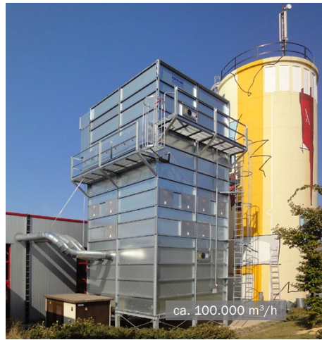
MultiStar Rührwerkfilter mit Jetabreinigung
