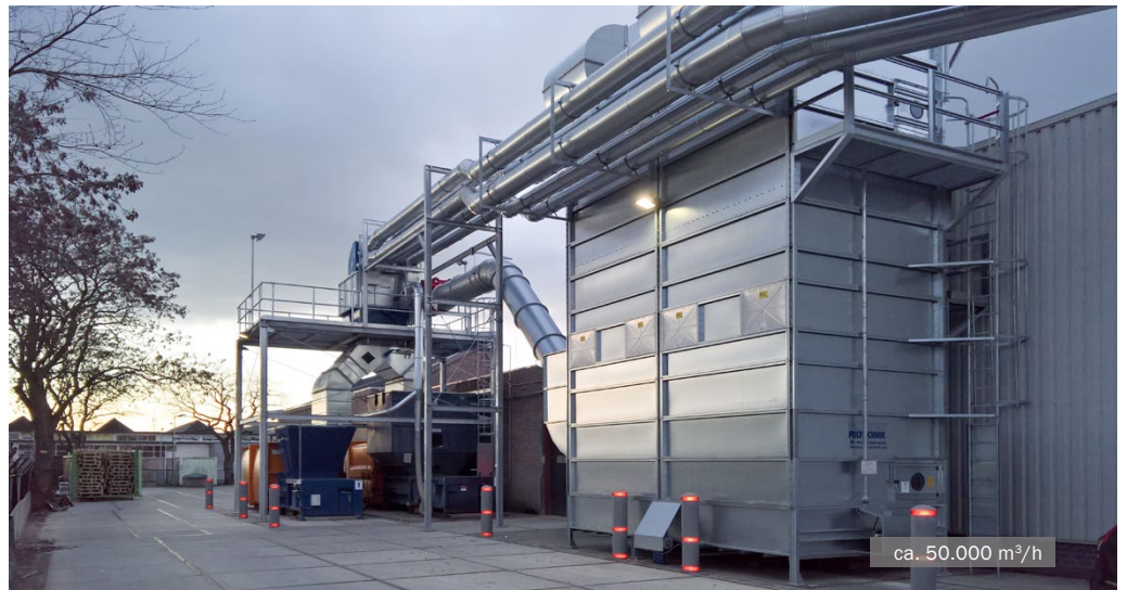
MultiStar Schubbodenfilter mit Jetabreinigung • Druck- und Verpackungsindustrie
