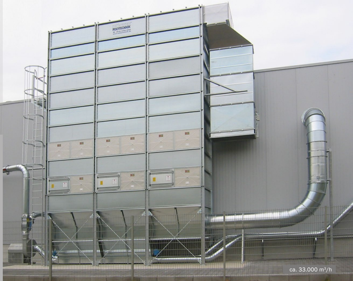
MultiStar Schleusenfilter mit Überbläsung • Möbelfertigung
