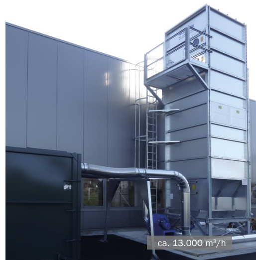
MultiStar Schleusenfilter mit Containerbeschickung
