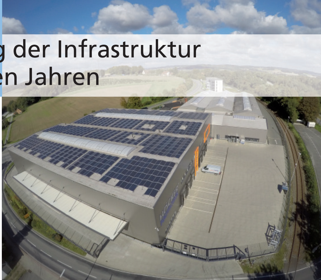
Schritt für Schritt wurde die gesamte Infrastruktur erneuert und auf dem neuen Logistikzentrum erzeugt eine leistungsstarke Photovoltaikanlage sauberen Strom. Bild: Höcker Polytechnik
