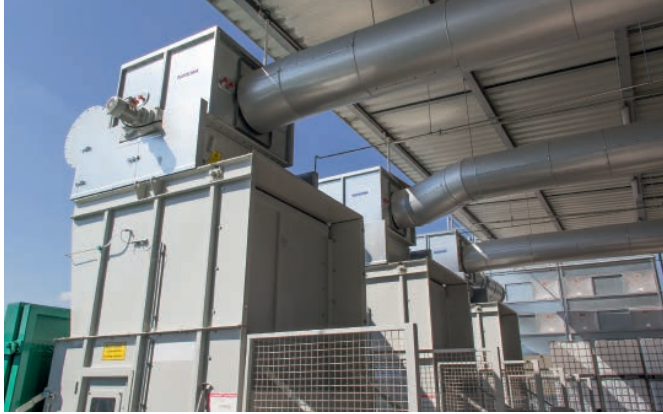
Höcker Polytechnik Materialabscheider trennen Produktionsreste aus dem Luftstrom.
